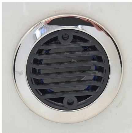
Abbildung 12: Rücklaufgitter im tiefen Bereich des Whirlpools
