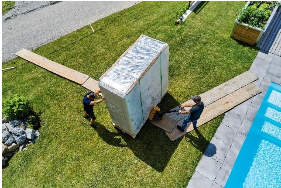
Abbildung 1: Transport eines Whirlpools über die Wiese mittels Hubwagen und Holztafeln (links) Umkippen des Pools am Bestimmungsort (rechts)
