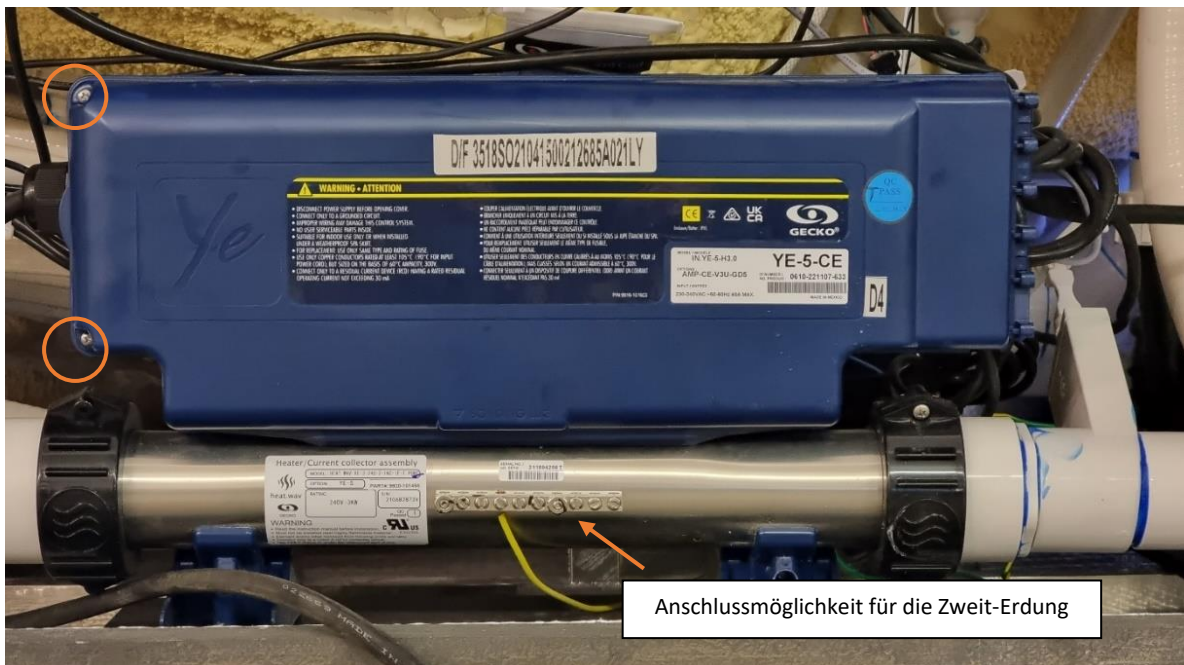
Abbildung 6: Gecko Steuerung, Position der Gehäuseschrauben und Zweit-Erdung
