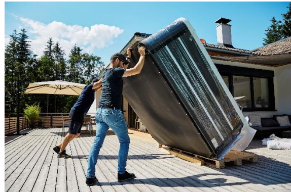
Abbildung 1: Transport eines Whirlpools über die Wiese mittels Hubwagen und Holztafeln (links) Umkippen des Pools am Bestimmungsort (rechts)
