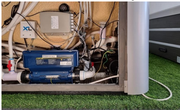
Abbildung 5: Kabeleinführung über die Ecke
